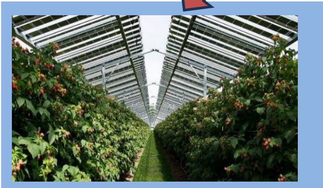
Dauerkulturen: Anlage mit halbtransparenten bifazialen Modulen
