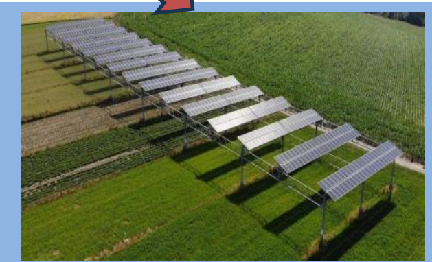
Ackerland: nicht nachgeführte bifaziale Module in 5,5 m Höhe, Neigungswinkel 20%
