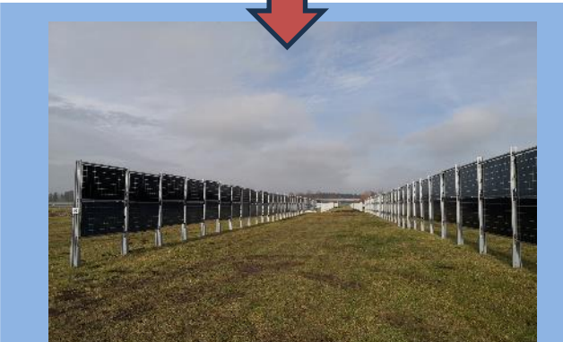
Grasland: bifaziale, vertikale Module in Ost-West-Anordnung
